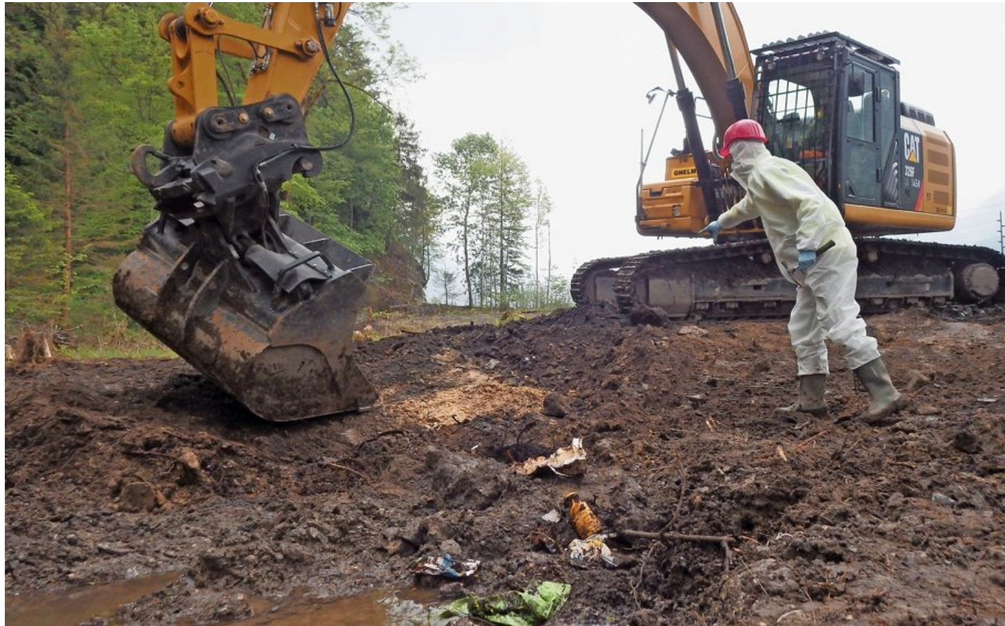
Der Baggerführer trägt in dünnen Schichten sorgfältig Material ab. Für dessen Triage ist Florian Klingenfuss (im Schutzanzug) verantwortlich. Foto: Sibylle Hunziker
